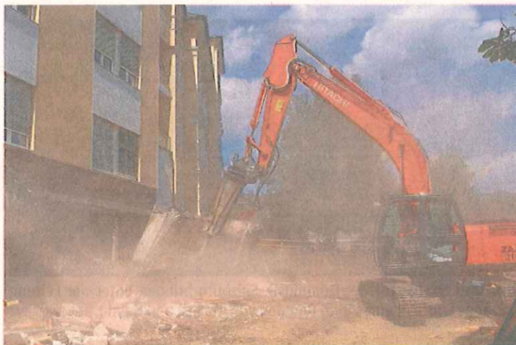
Mit dem Abriss der alten Küche begannen die Arbeiten.
