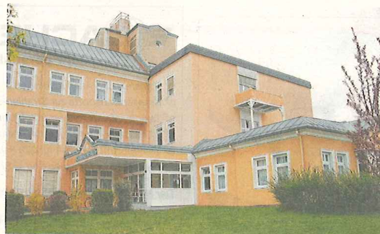
Über der Cafeteria (rechts) wird aufgestockt.
