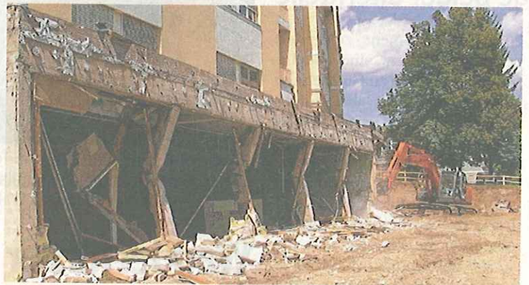
Zwei Millionen Euro investiert das Land Salzburg am Krankenhaus Tamsweg allein in den Neubau der Spitalsküche. Foto: KH Tamsweg
